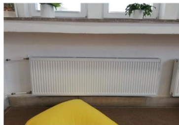
Výmena radiátorov v MsK Partizánske
