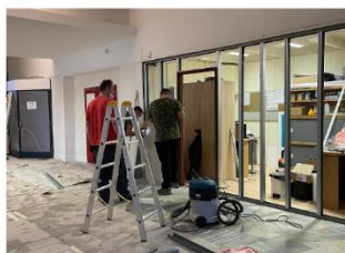
Úprava vstupného vestibulu / odstránenie sklenených výklenkov, zarovnanie stien
